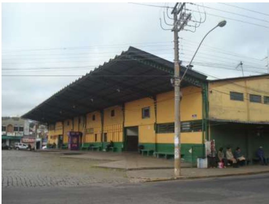
Foto 12- Terminal Rodoviário em frente ao Auto Posto
