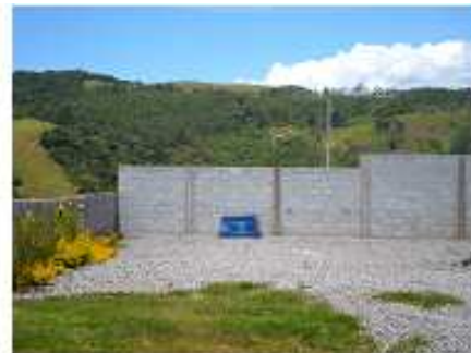
VISTA DOS FUNDOS DO TERRENO
