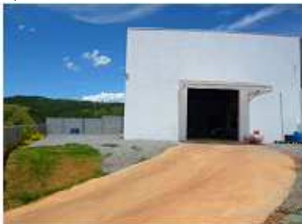
VISTA DA FACHADA-R.FRANCISCO DE S.D.GUIM.
